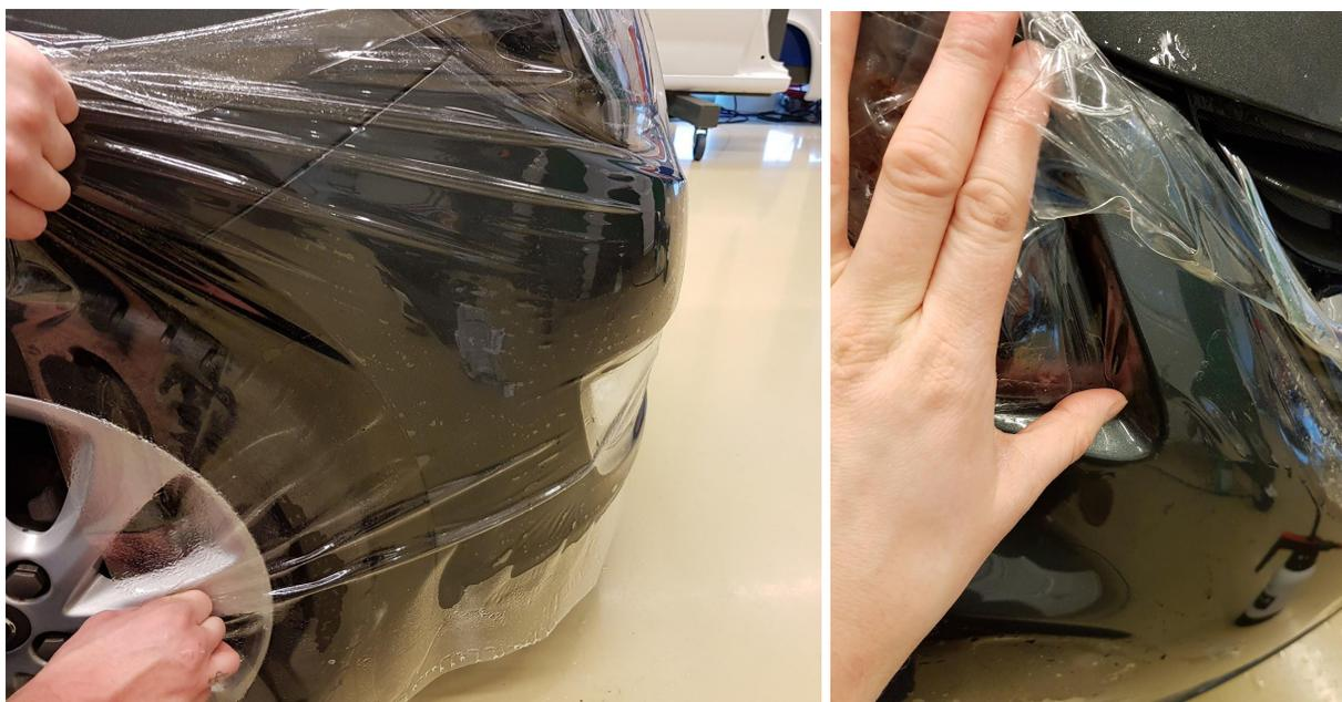
Le film Avery Dennison Pure Defense PU présente un bon degré de conformabilité. Par conséquent, il convient généralement pour recouvrir les formes conventionnelles convexes et composées de l'avant des voitures. Néanmoins, dans les formes aux ondulations profondes, il
