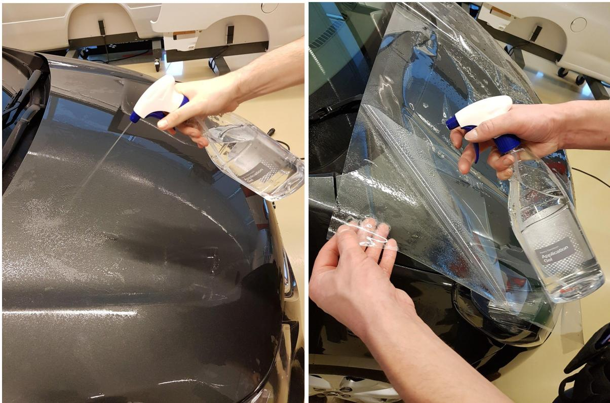
Retirez le support dorsal et pulvérisez le côté adhésif exposé avec la solution savonneuse. Positionnez ensuite le matériau sur la zone de pose sélectionnée. Au besoin, faites glisser le film jusqu'à ce que vous ayez atteint le bon positionnement. Tirez le film pour l'adapter à la surface de pose, en le posant à plat et en enlevant toutes les plis.
