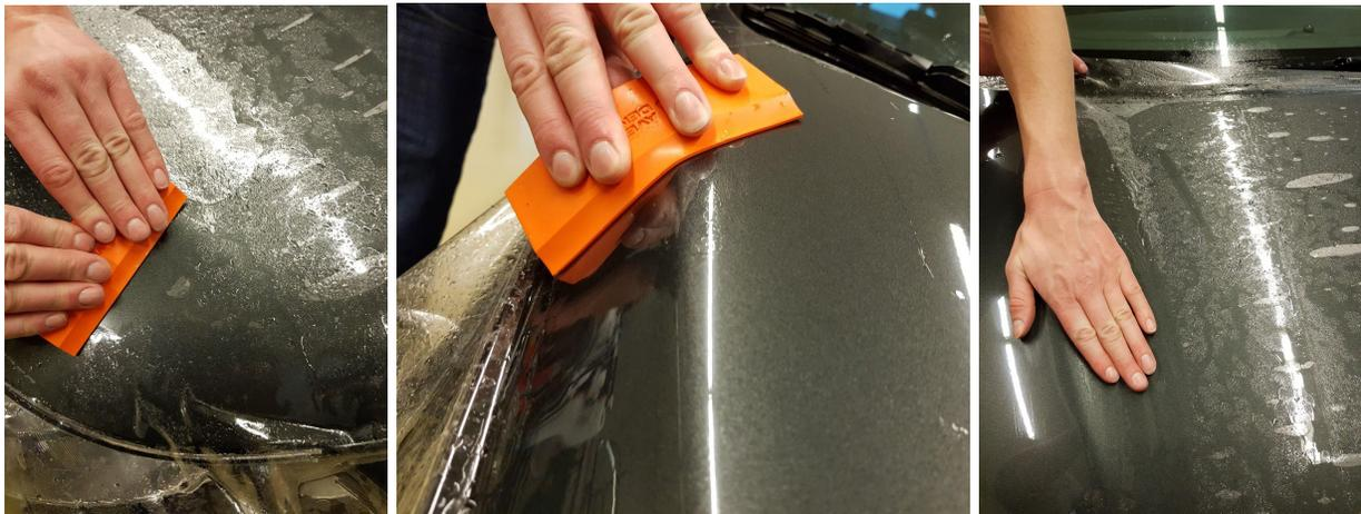
Wenn Sie Avery Dennison Pure Defense PU- oder PVC-Folie nutzen, kann sie nur nach dem erstmaligen Auflegen bzw. nach leichten Rakelstrichen, die ohne Druck erfolgten, noch neu positioniert werden. Versucht man es danach, können feine Linien auf der Folienoberfläche sichtbar bleiben.
